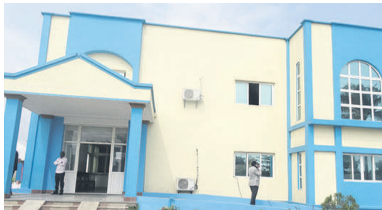
Façade principale de la polyclinique
