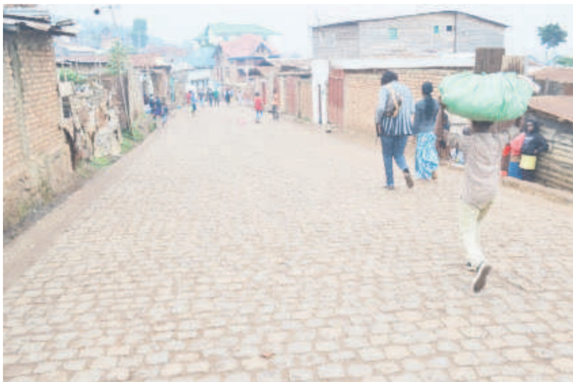
Une rue réhabilitée du quartier Mosala.
