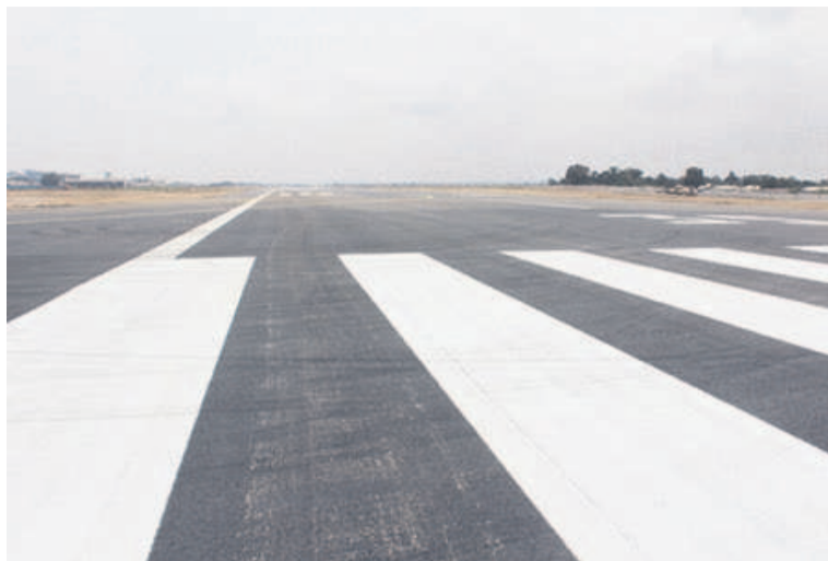
Une vue de la piste rénovée / crédit photo Adiac
