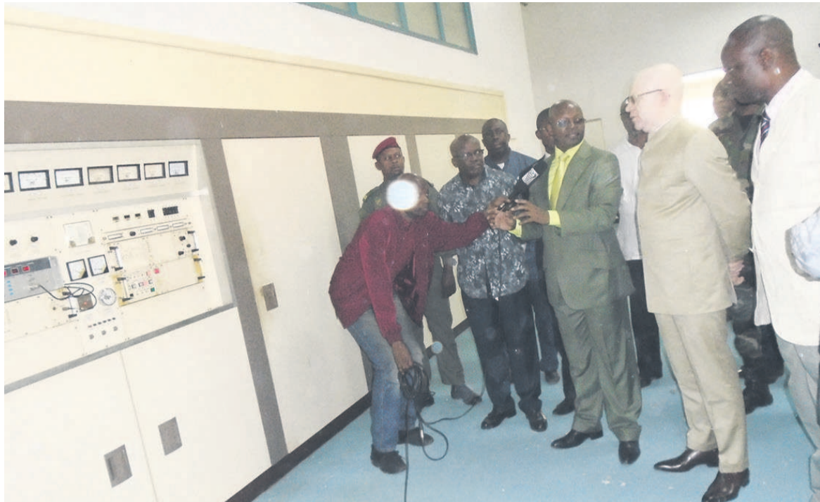
Thierry Lézin Mougalla visitant les installations techniques du centre émetteur du Djoué (photo adiac)
