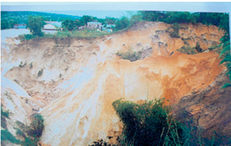
Cette zone de glissement de terrain est située après le marché Bas Prix au quartier Kombo entre les rues Oyalé et Botoka, en descendant vers la zone Lounda, située au quartier Jacques Opangault (adiac)
