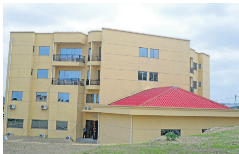
Une vue des bâtiments réhabilités
