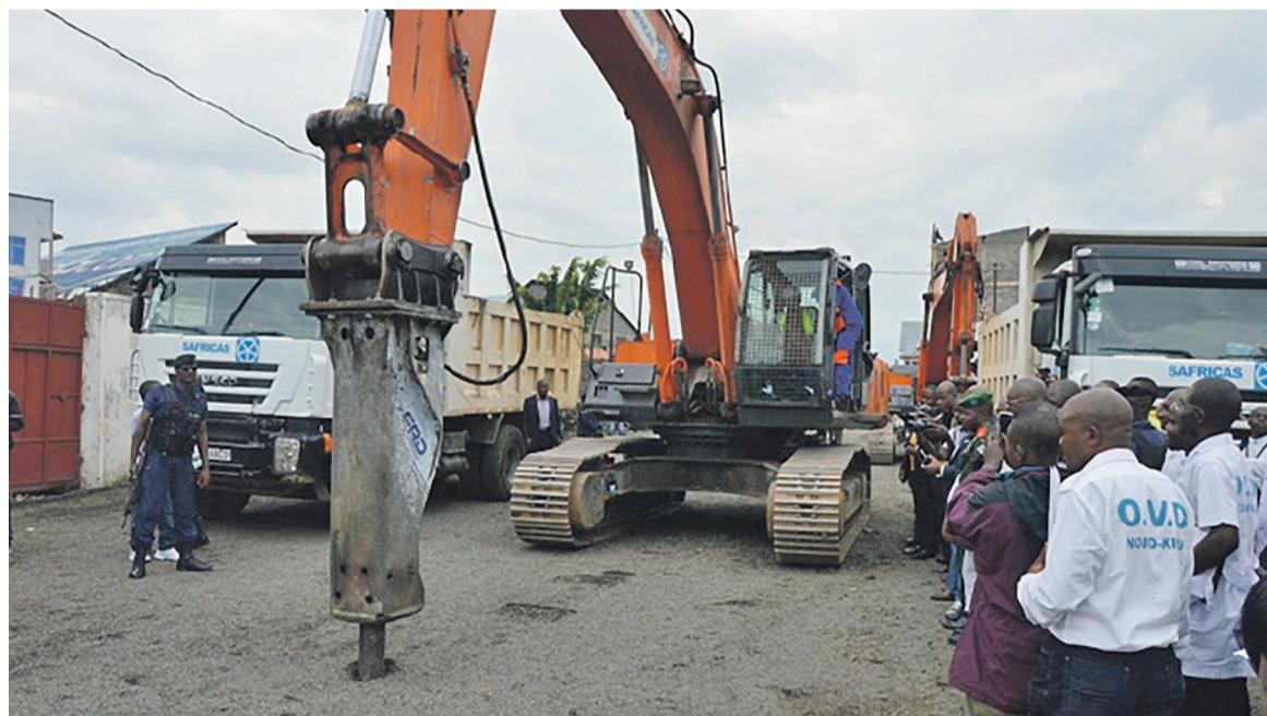
Le gouverneur Julien Paluku, donnant un coup du marteau-piqueur pour lancer les travaux./Photo CEPTM
