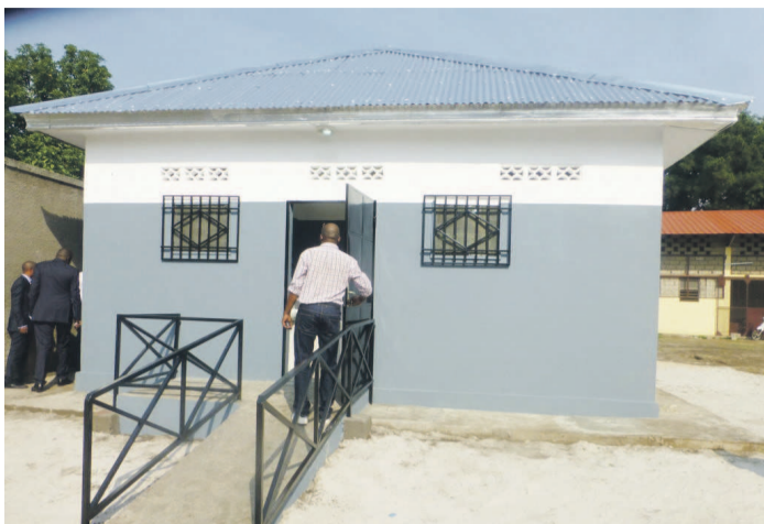
Une vue du bâtiment abritant les toilettes
