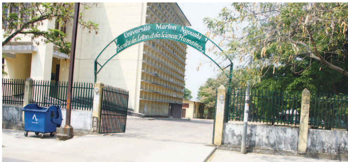
Façade principale de la Faculté des lettres/adiac
