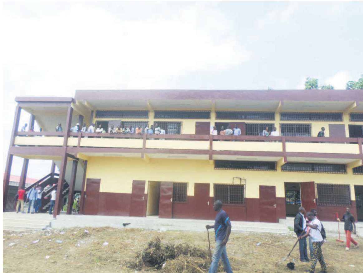
Le bâtiment R+1 construit à l'ENS/crédit photo Adiac
