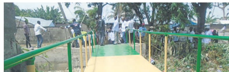
Une vue de la passerelle construite dans le quartier Devala (photo adiac)
