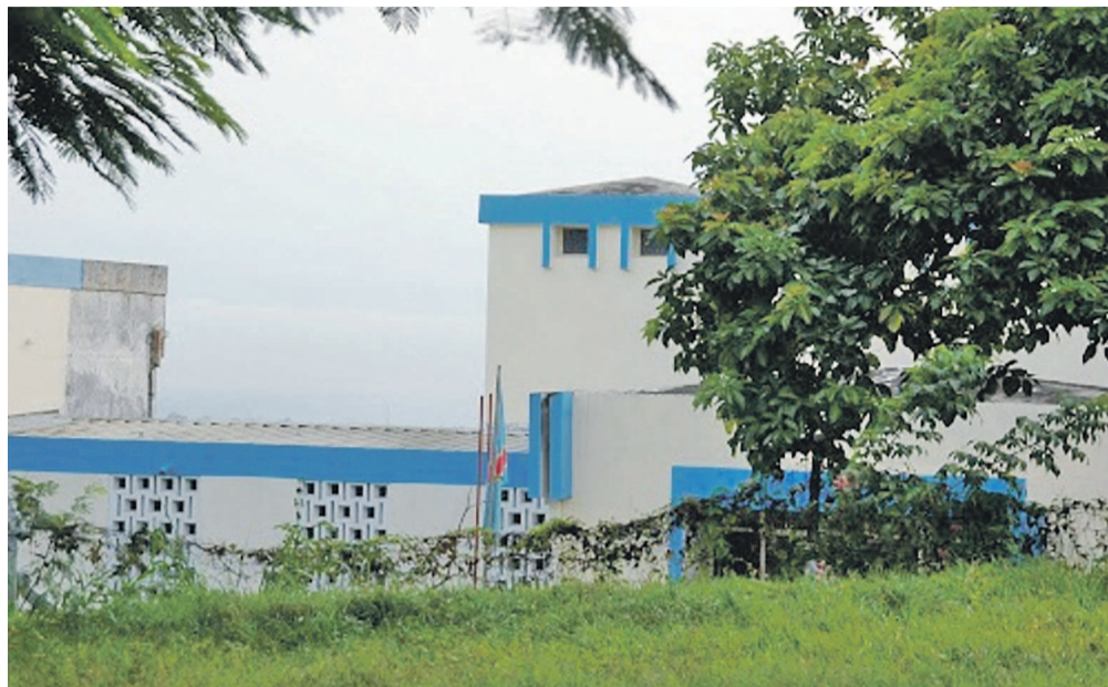
Centre régional de recherche nucléaire de Kinshasa (CREN-K)
