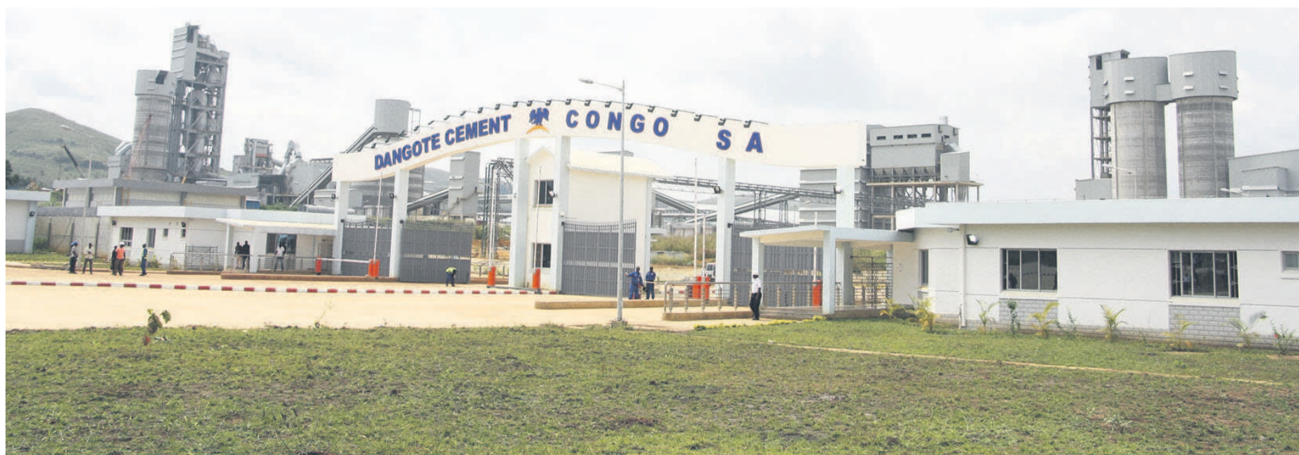
Vue de la façade principale de l'usine de Yamba (Adiac)
