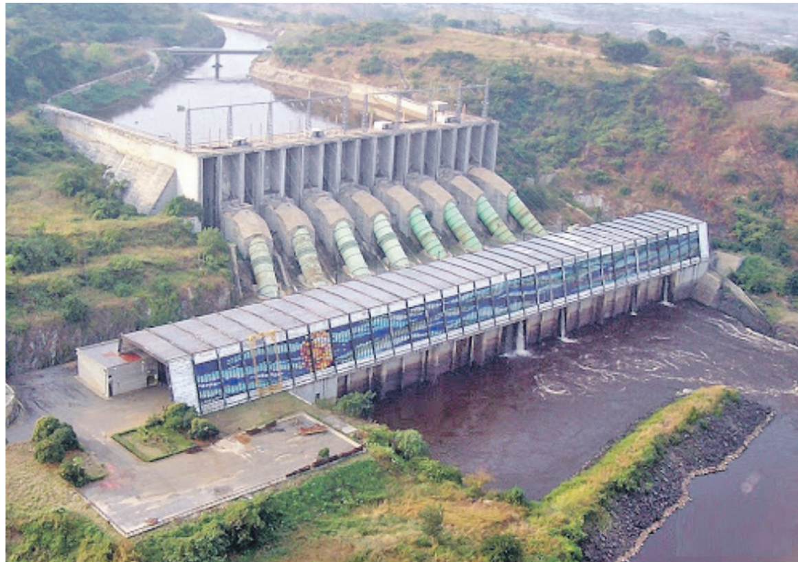
Le site du barrage d'Inga.
