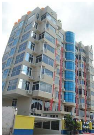
Immeuble abritant la Direction générale de l'Ogefrem
