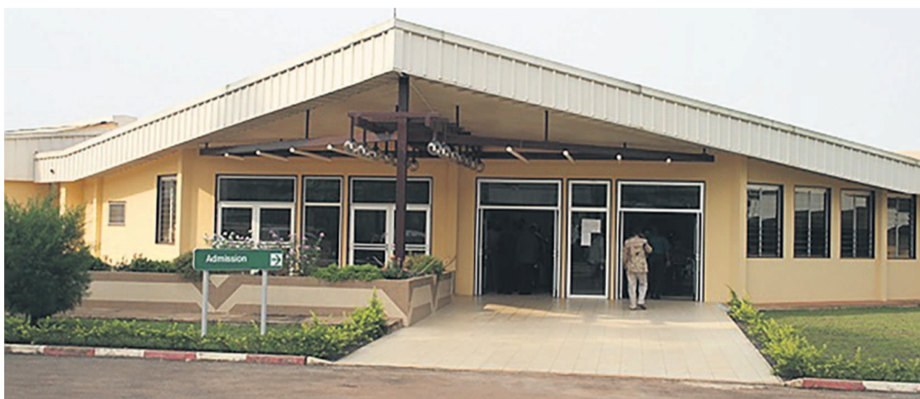
Façade principale de l'hôpital général de Dolisie (photo Adiac)
