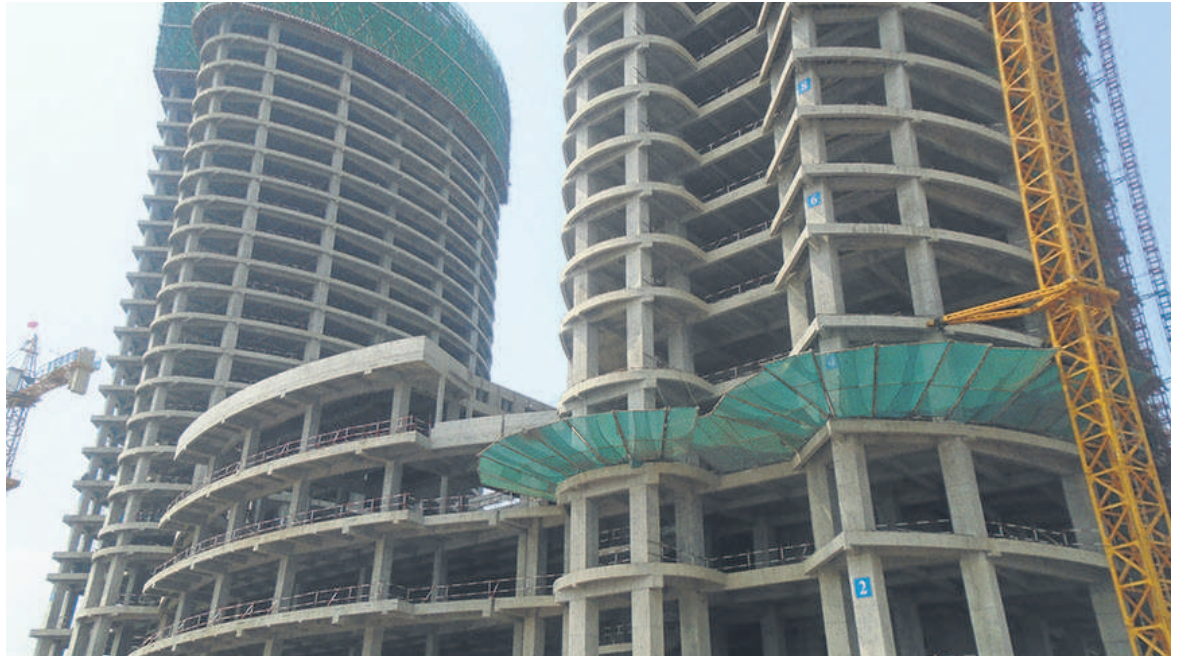
Une vue de l'ossature des Tours jumelles de Mpila (photo adiac)
