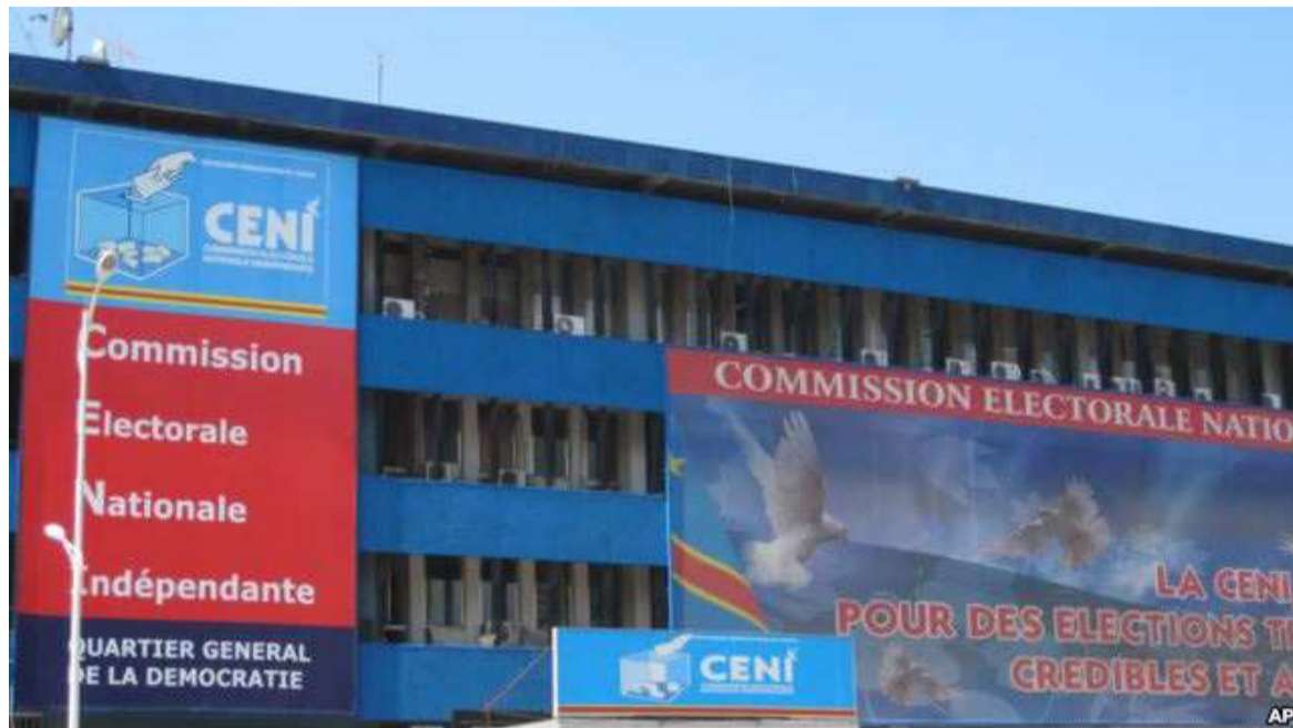
Le siège de la Ceni sur le boulevard du 30 Juin
