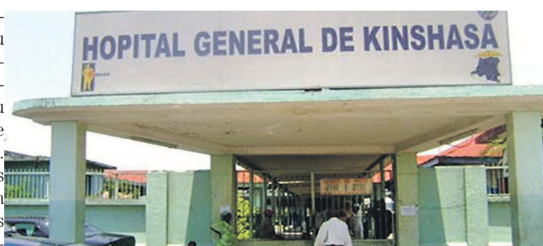
Hôpital Général de Kinshasa
