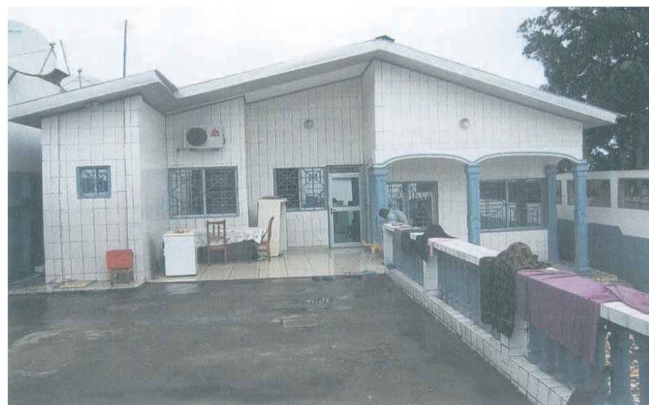
FACADE PRINCIPALE GRANDE MAISON
