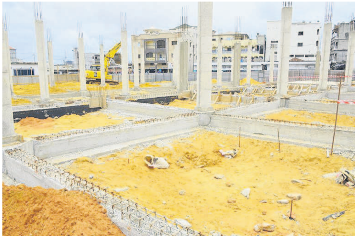
Travaux de construction du nouveau marché central de Pointe-Noire/DR
