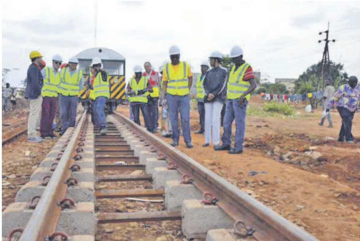
La visite des chantiers sur les tronçons des voies réhabilitées et en réhabilitation entre Lumata et Lubumbashi/CEPTM
