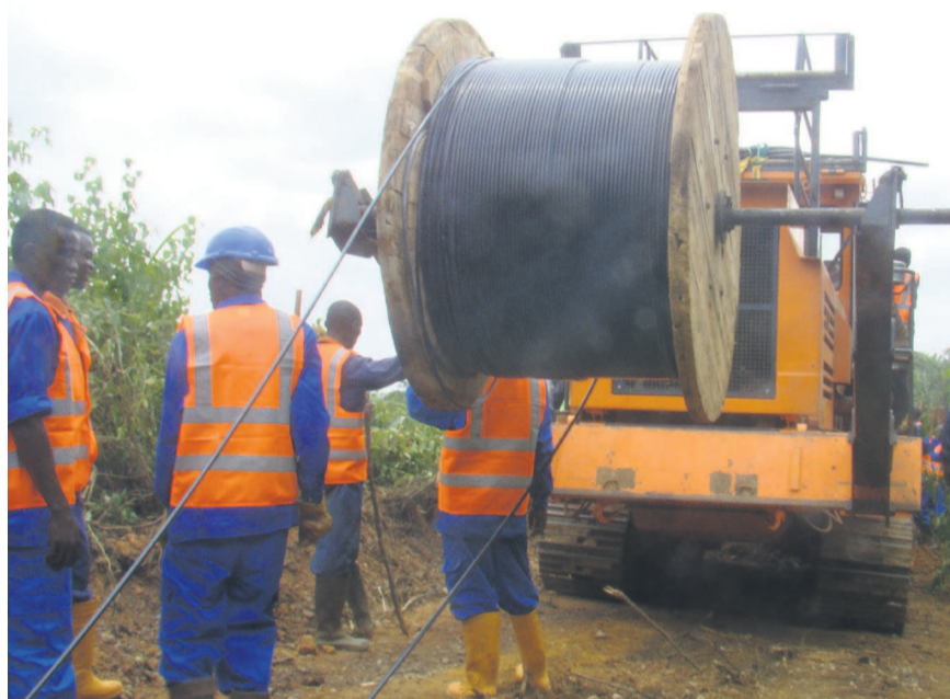
Les techniciens à pied d'oeuvre pour la connexion internet à haut débit
