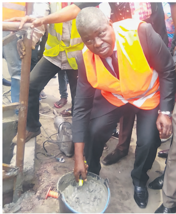
Anguios Nganguia Engambé lançant les travaux/Photo Adiac
